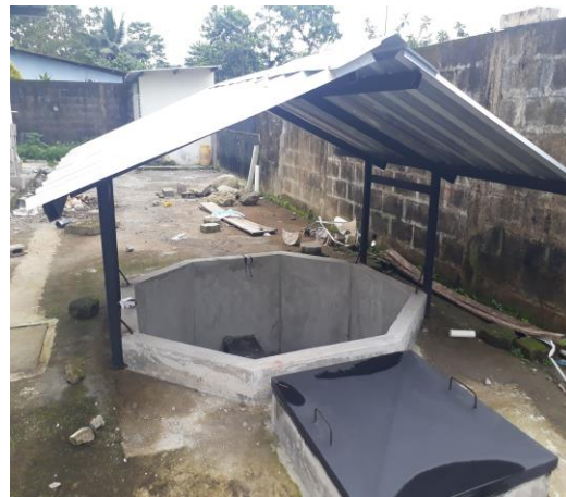
Construcción de Cisterna
